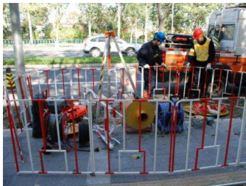
图 4-2 作业现场围挡
