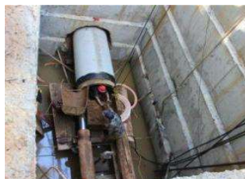
(e) 深基坑和地下管沟
