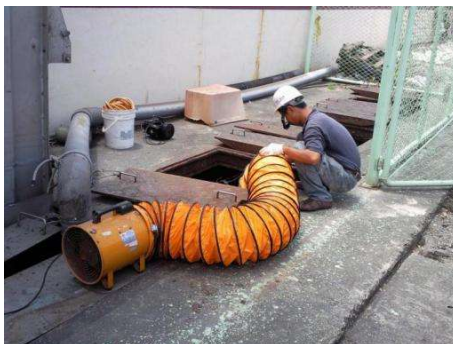
图 4-6 风机、风管的设置
